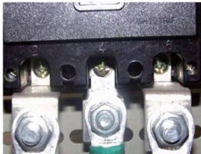
端子通过连接附件与设备连接图示
