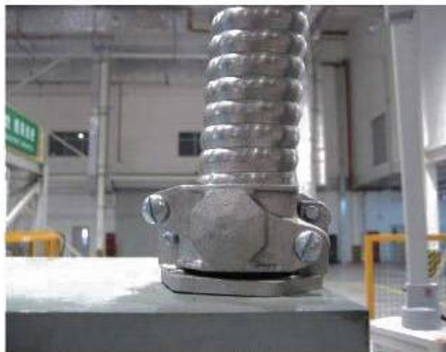
电缆铠装接地图示
